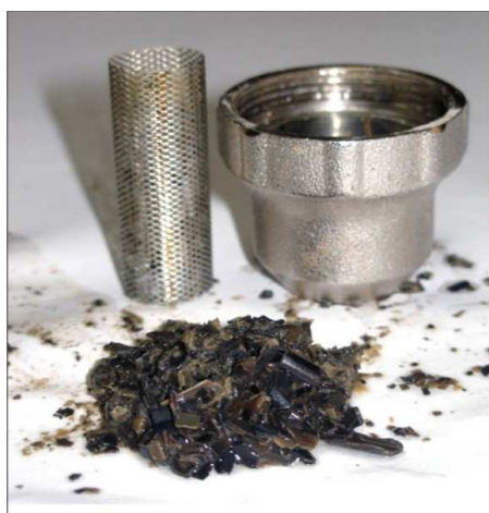
Отслоившаяся в результате термической деформации накипь с теплообменника газового котла
